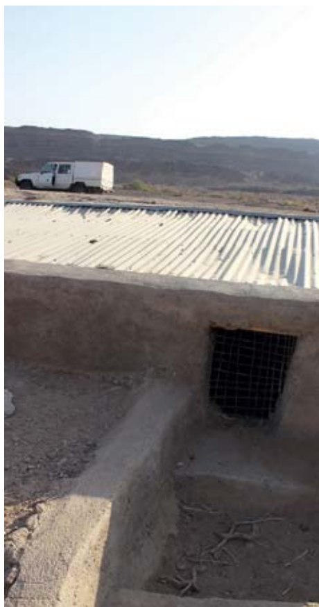
Abb. 6: Durch zwei bis drei der Birka vorgeschaltete Auffangbecken wird ein Großteil der mitgetragenen Partikel sedimentiert. Der Wassereingang ist vergittert.
